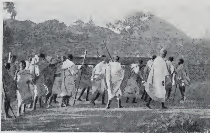
Abb. 6. Herbeischaffen des Bauholzes.
